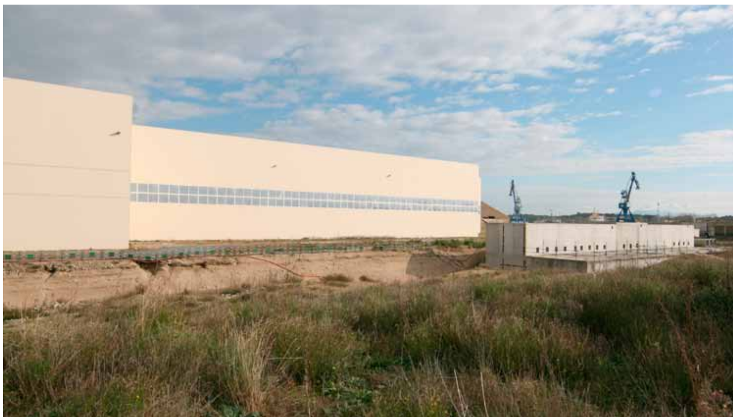
L'unité de production du Laminoir des Landes à Tarnos est quasiment achevée
